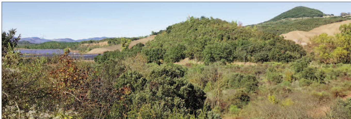
À droite et de couleur sable, le site en exploitation. À gauche et de couleur indigo, deux champs de panneaux photovoltaïques.
