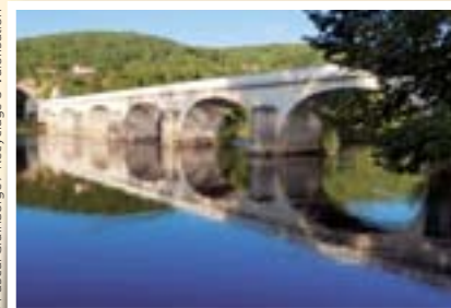
Premier ouvrage cimenté, le pont de Souillac (Lot).
