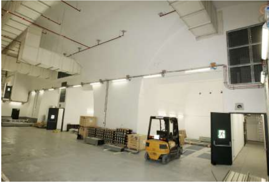
Installation des équipements dans les alvéoles du 3 PS
