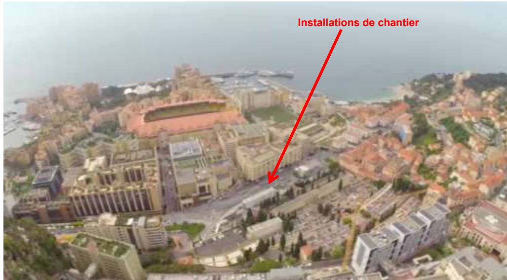
Chantier Tunnel Descendant Ouest
