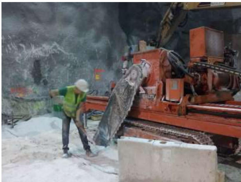
Sciage pour le pré-découpage du stross
