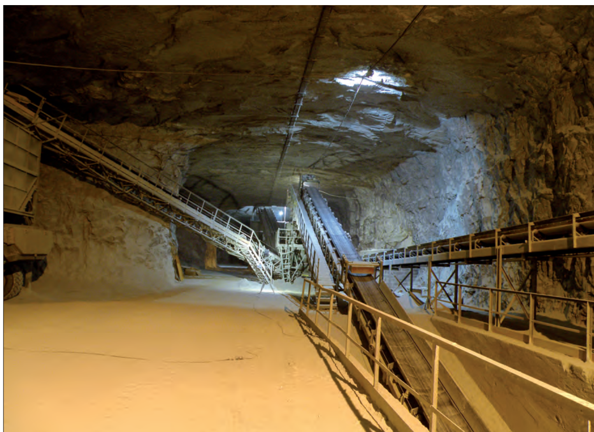
Galerie souterraine avec les convoyeurs chargés d'approvisionner les deux fours
