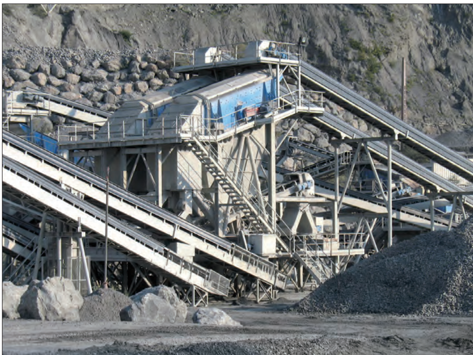
Adossés à la montagne, les équipements sont protégés par des enrochements
