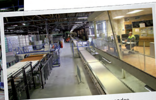
La salle de contrôle regroupe les commandes de la plâtrière, de la table de fabrication et du sécheur. L'ensemble est piloté par un ordinateur qui programme la fabrication souhaitée
