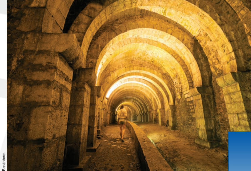
Galerie souterraine, immense voûte de pierre de 165 m de long entre les deux puits (aval et amont), sur 10 m de haut.
