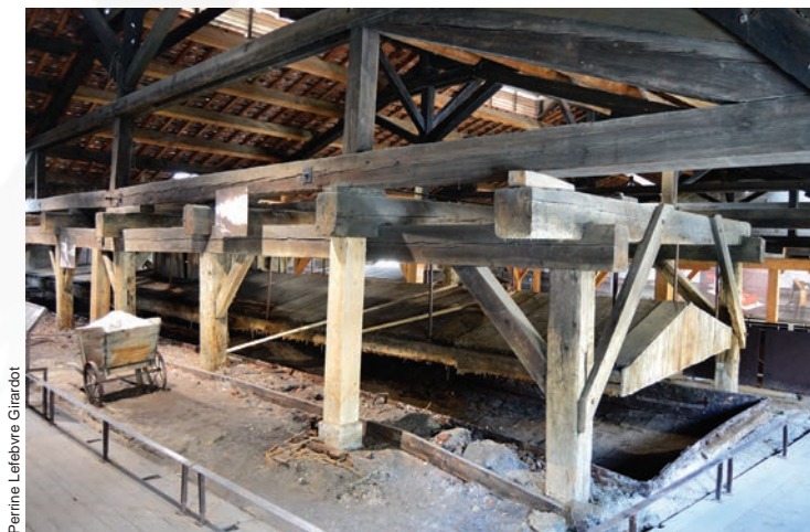
Bâtiment d'évaporation où est envoyée la saumure pour produire le sel ignigène. Le sel est récolté par les sauniers dans de vastes cuves métalliques appelées poêles. La chaleur y est étouffante : quasiment 50 °C avec un taux d'humidité entre 70 et 80 %.
