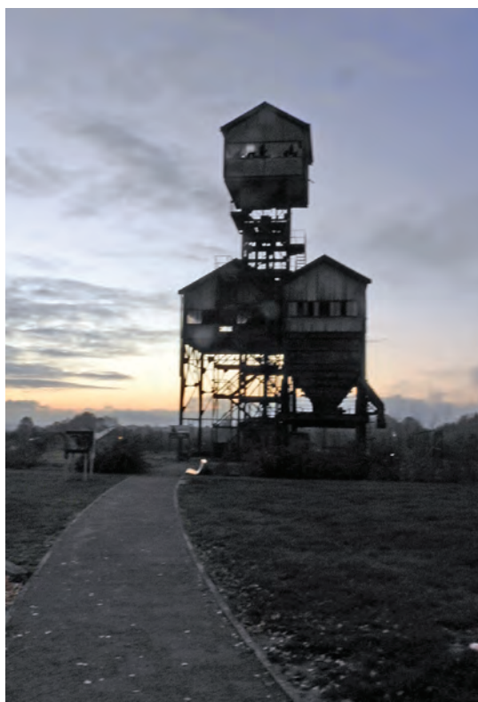
Le dernier chevalement des Ardennes, au puits Saint-Quentin, a été inauguré en 1961. Il permettait de descendre par groupe de douze entre 90 et 120 m de profondeur, en une demi-minute. Arrêté en 1971 avec la fermeture du puits, il résiste aux intempéries et demeure le témoin de l'activité ardoisière de Rimogne.
