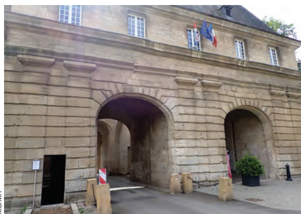
La Porte de France, à Marsal, est un vestige des fortifications de Vauban. C'est l'une des entrées à l'ancienne cité du sel.
