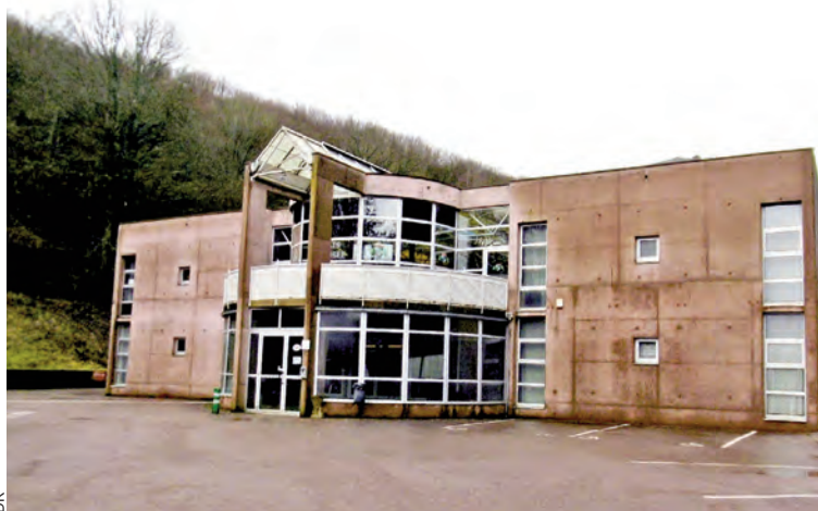
Bâtiment du musée des mines de fer de Neufchef. Le choix de l'aspect extérieur, résolument contemporain, privilégie l'intégration dans une vallée dénuée de structures industrielles authentiques. La conception du bâtiment a été confiée au cabinet d'architecture thionvillois Morel, et réalisée par l'entreprise Lutzweiler.
