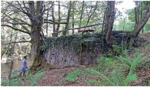
Cage maçonnée de la roue d'exhaure de la mine Saint-Louis, terminus du cheminement en visite libre.
