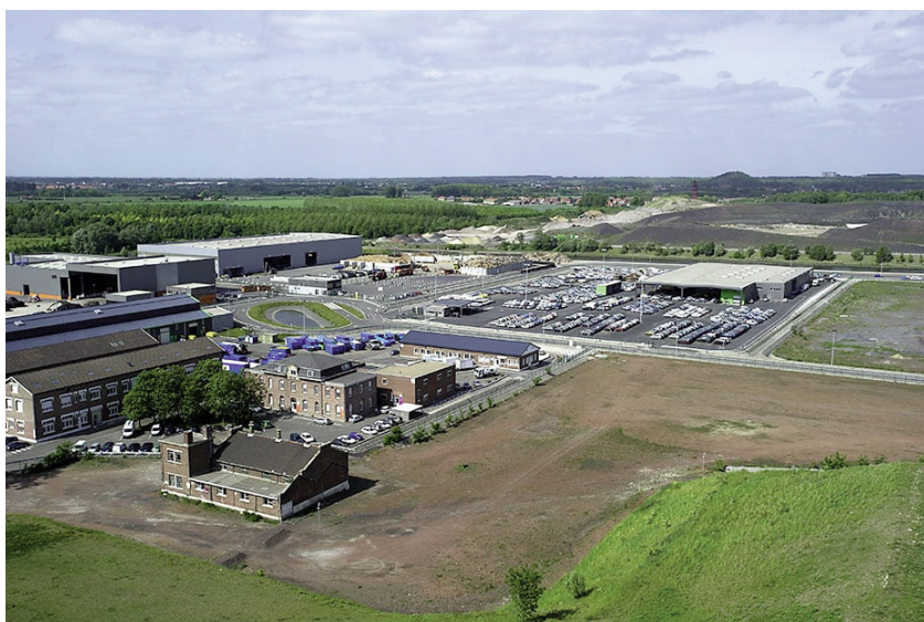
Vue générale de l'Ecopôle de Suez à Noyelles-Godault
