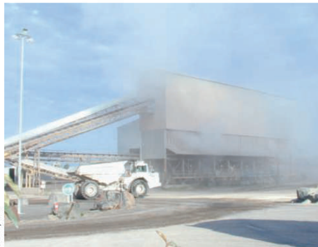
Installation sans traitement des poussières
