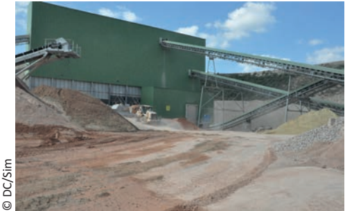
Carrière de grès - Bretagne : installation de traitement bardée
