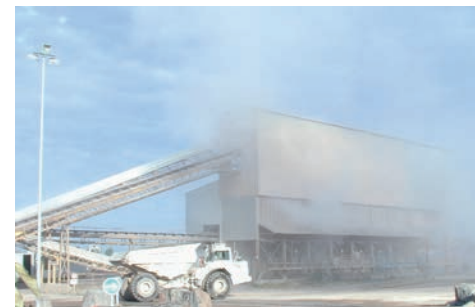
Carrière en Normandie : installation sans dépoussiérage
