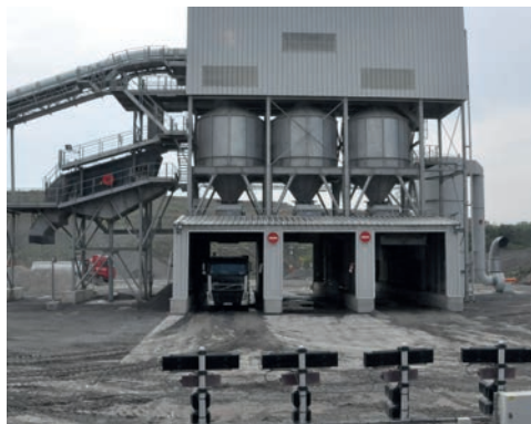
Postes de chargement automatique bardés
