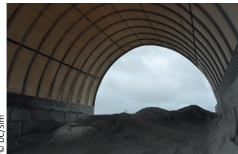
Hall de stockage de sables secs fillerisés
