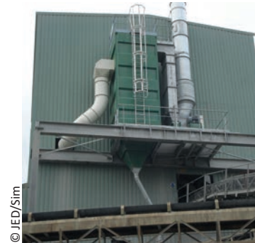
Dépoussiérage centralisé ajouté en extérieur d'un bâtiment fermé de criblage ; les fines sont renvoyées dans les graves
