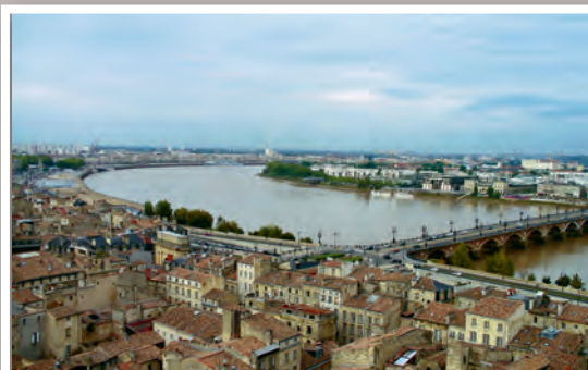
Sur la rive gauche, le port de la Lune et le pont de pierre (1822).
