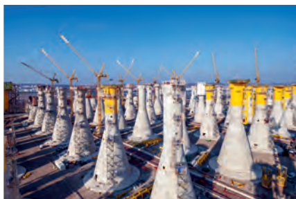
Fabrication des 71 fondations gravitaires du parc éolien de Fécamp (Seine-Maritime).
