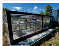
Tête d'un des puits géothermiques de l'Aquifer Thermal Energy Storage (ATES) de l'Ensegid.
