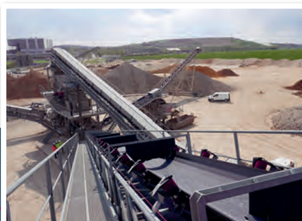
Recyclage de matériaux inertes à la MEL Eurovia de Bondoufle (Essonne).
