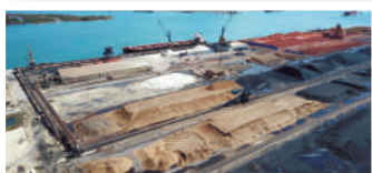
Vue aérienne du terminal Minéralier de Fos.
