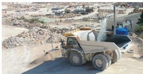
Remplissage de la benne
