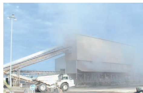
Carrière en Normandie : installation sans dépoussiérage
