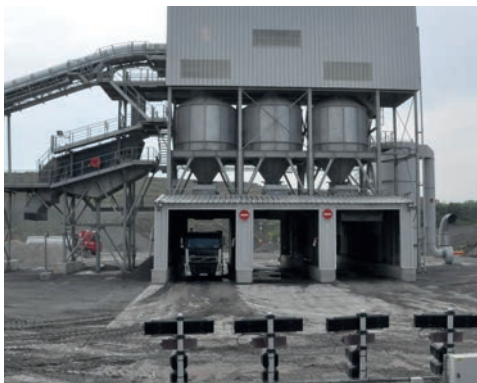
Postes de chargement automatique bardés
