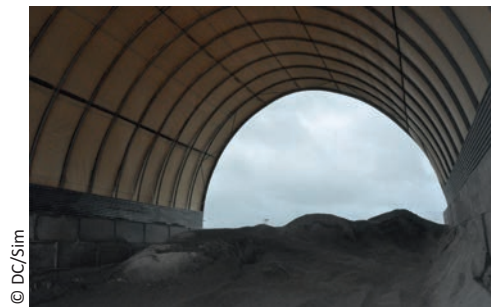
Hall de stockage de sables secs fillerisés
