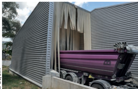
Trémie bardée avec rideau pour limiter les émissions au vidage
